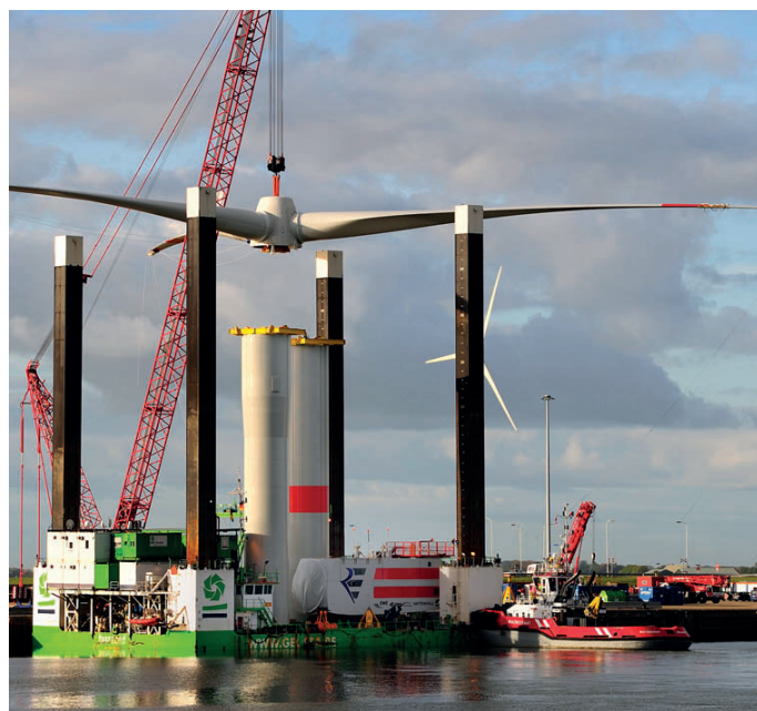
alpha ventus: Der Aufbau ist eine logistische Meisterleistung
