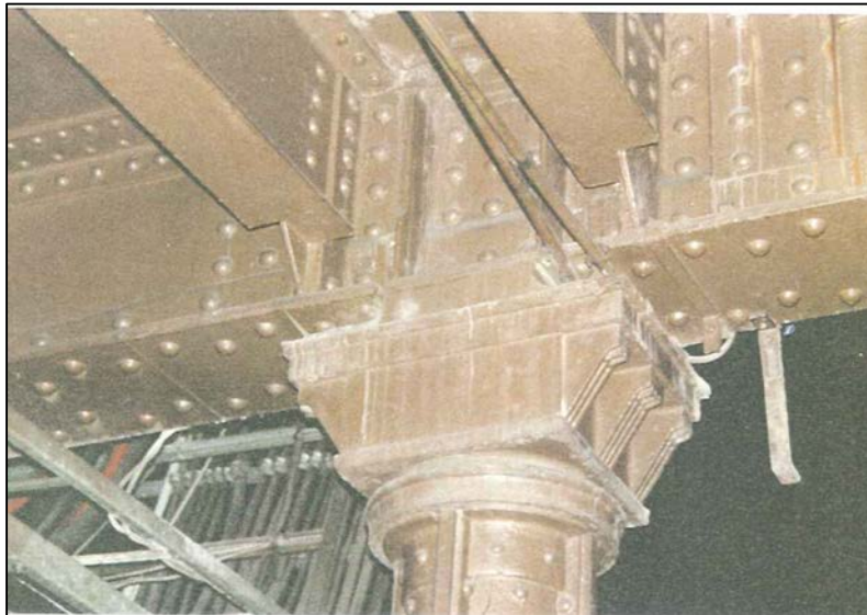
Quelle: Baubestandsanalyse Hauptbahnhof Hannover – März 1997
